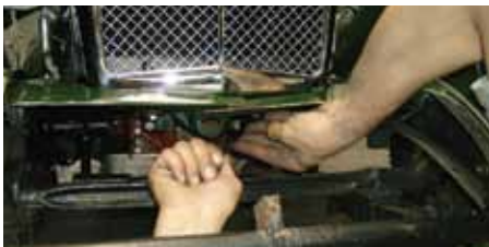
Jetzt wird der Kühler unten mit dem Fahrzeugrahmen verschraubt
