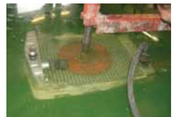
Ganz dicht? Mit einem Bar Druck erfolgt die Kontrolle unter Wasser
